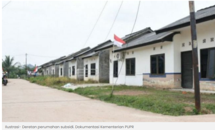
Ilustrasi- Deretan perumahan subsidi. Dokumentasi Kementerian PUPR
